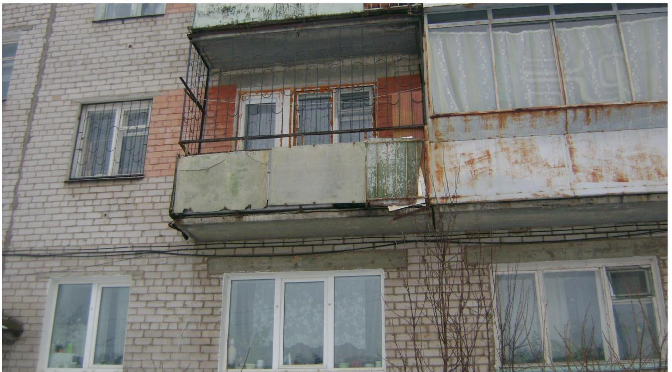
Фото 10. Фасад здания со стороны двора. Повреждения и коррозия металлических обделок и ограждений балконов.
