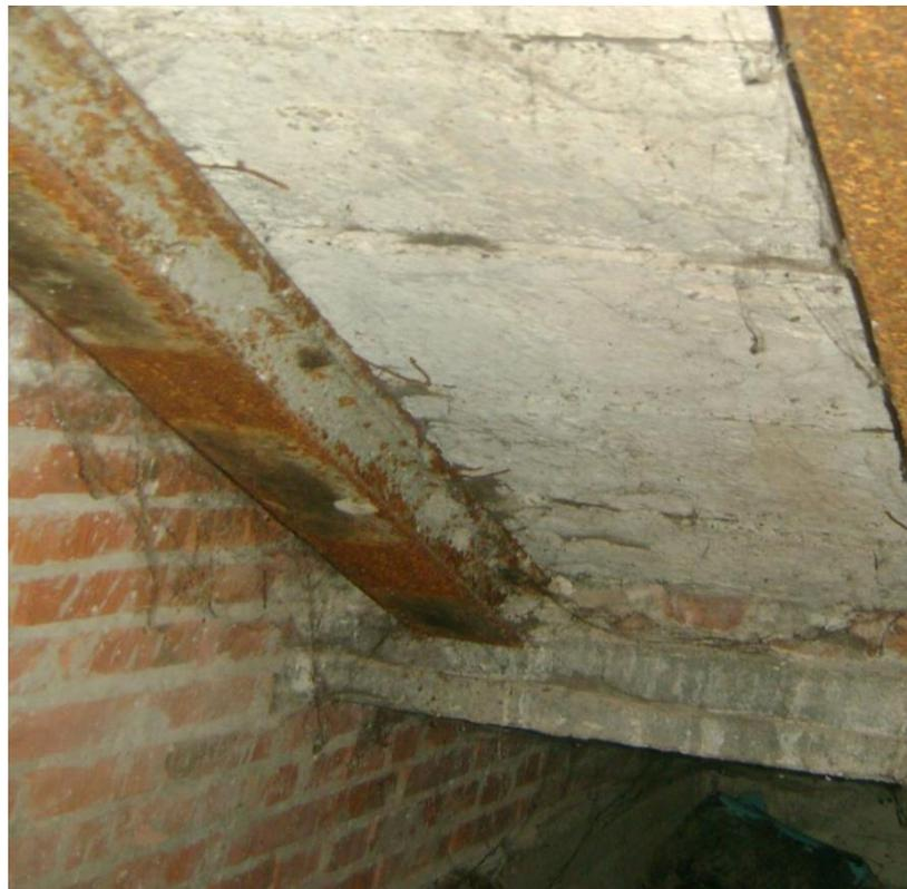
Фото 28. Лестничный марш со стороны технического подполья. Коррозия металлических косоуров. Местами отставание защитного слоя бетона.
