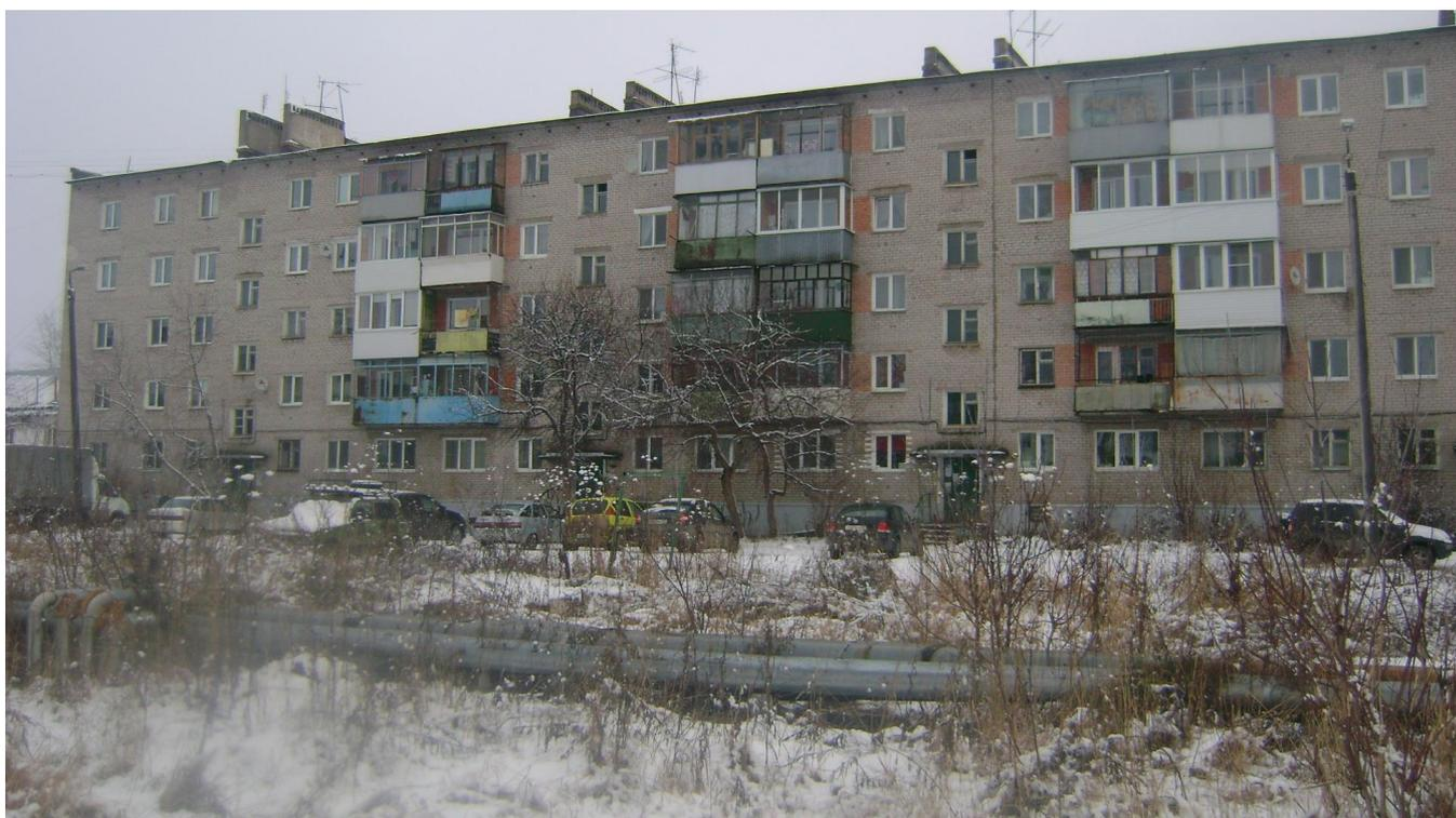
Фото 2. Фасад здания со стороны двора. Выветривание швов в кирпичной кладке.
