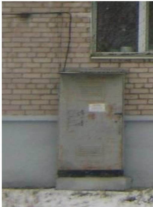
Фото 34. Торцевая сторона здания. Коррозия на поверхности металлических шкафов электрического оборудования, следы ремонта проводки.
