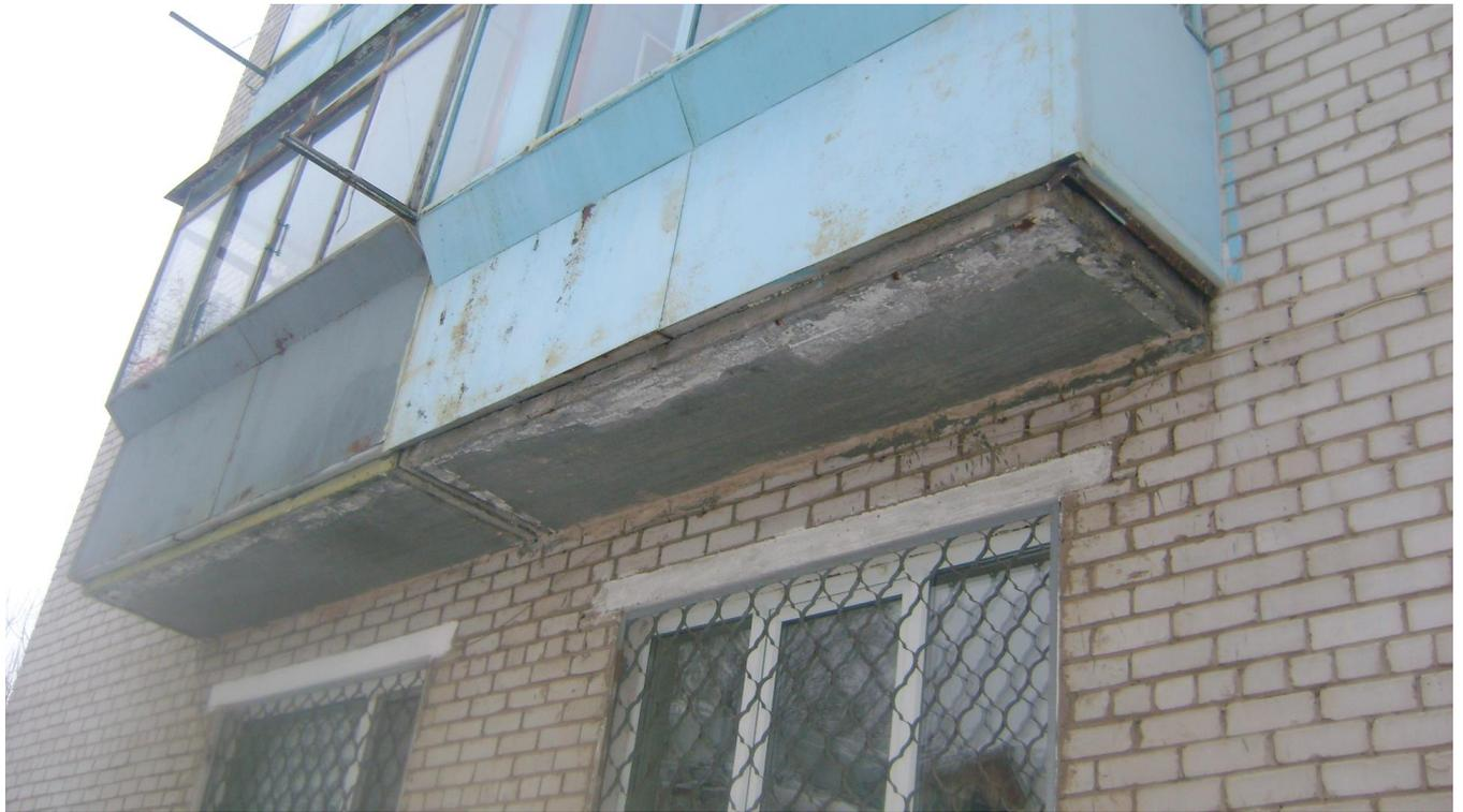
Фото 9. Балконы с торцевой стороны здания. Следы увлажнения на нижней плоскости плиты, высолы, повреждение металлических обделок и ограждений.
