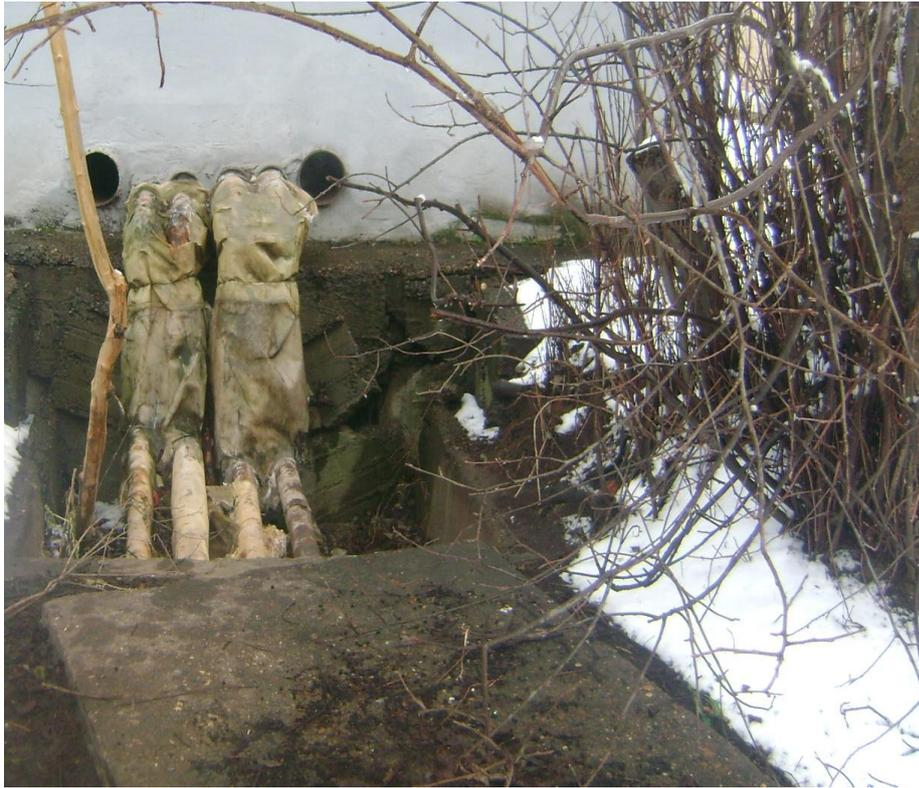
Фото 33. Фасад здания со стороны двора. Место ввода магистрального трубопровода в здание. Нарушение теплоизоляции трубопроводов.
