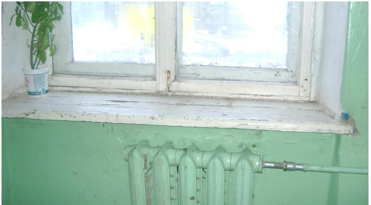
Фото 14. Оконные блоки в подъездах. Щели, трещины в местах сопряжения коробок со стенами, переплеты разошлись, древесина расслаивается, повреждение, отсутствие приборов, растрескивание, отслоение, загрязнение окрасочного слоя.
