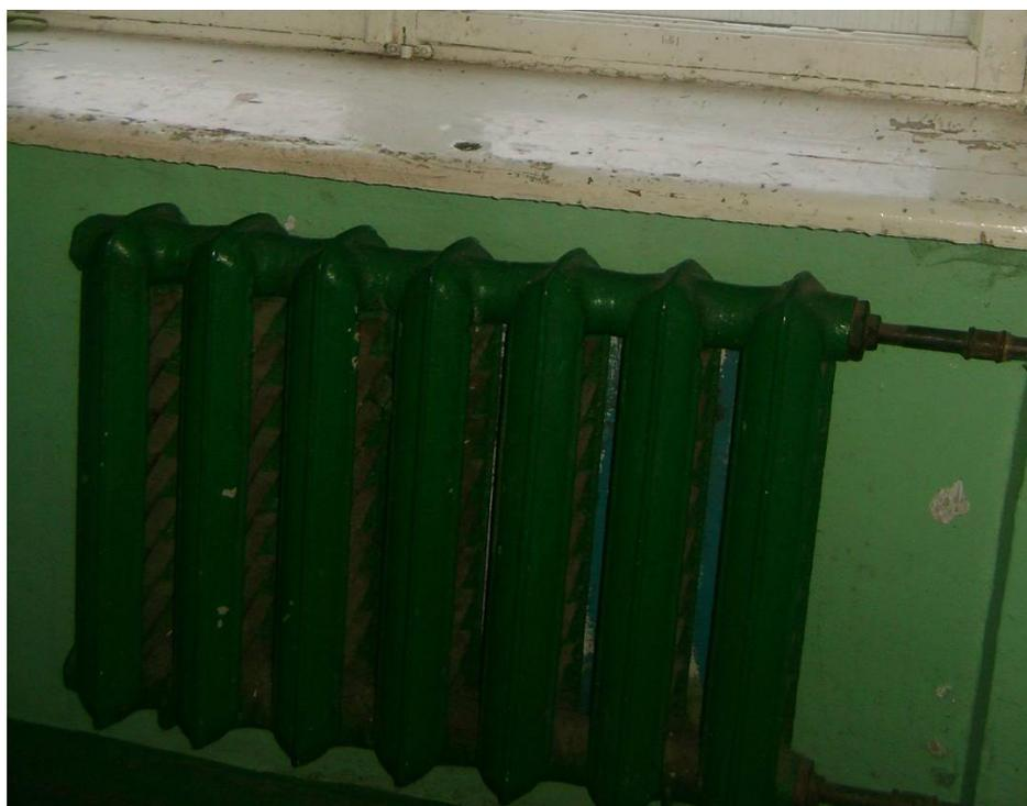
Фото 24. Подъезд. Следы ремонта трубопровода системы отопления.
