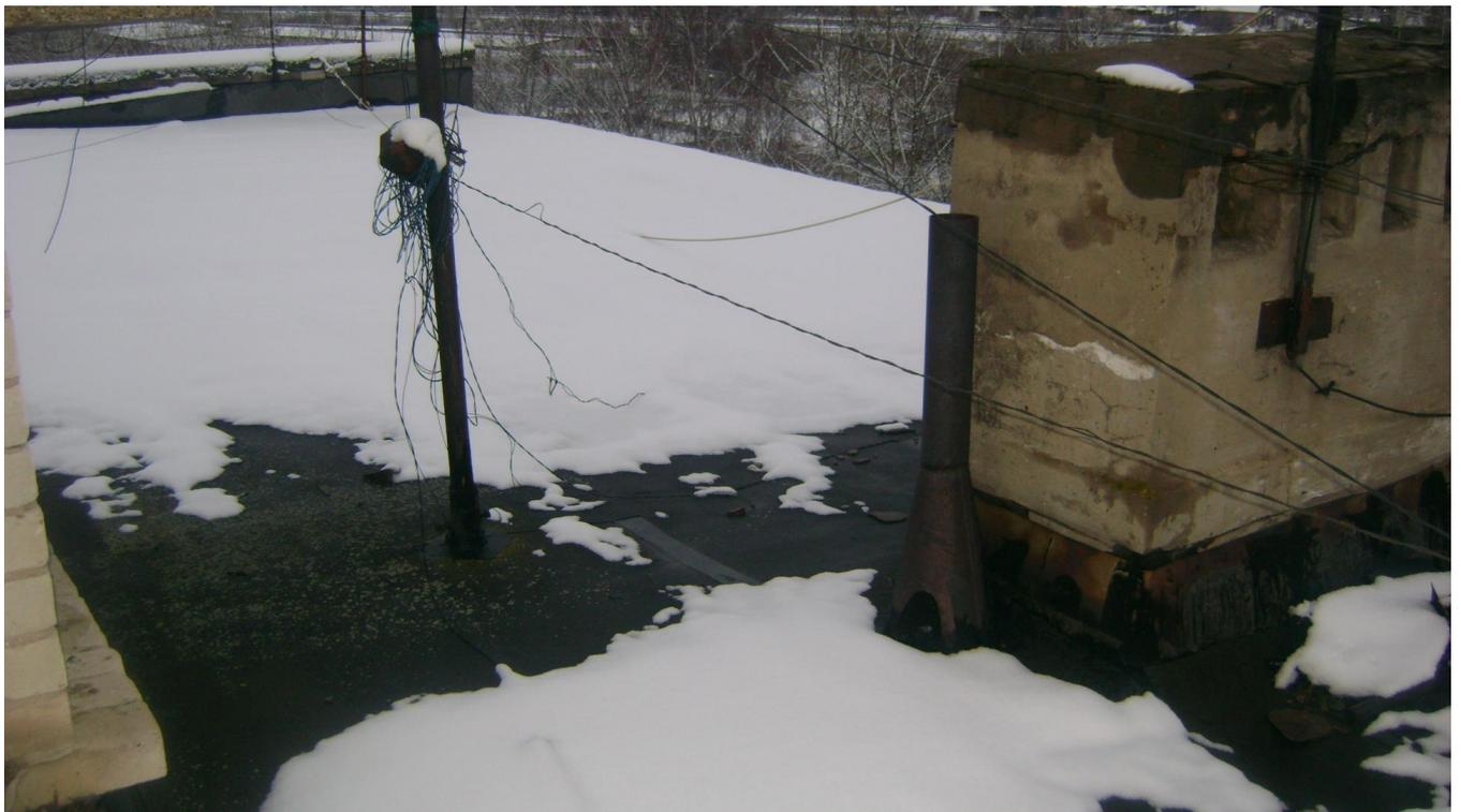
Фото 22. Крыша. Следы замачивания, трещины, сколы, отсывание штукатурного слоя вентиляционных шахт. Повреждения, вздутия верхнего слоя кровли.
