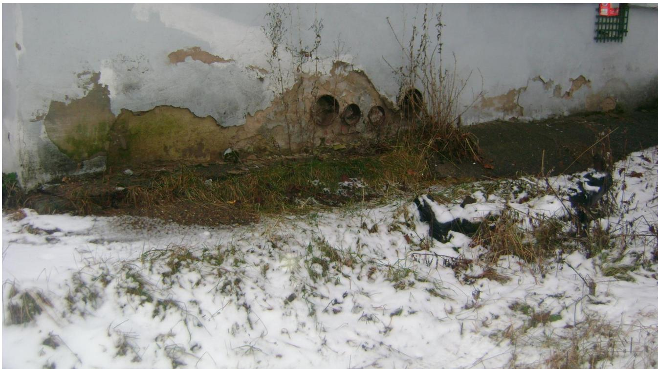
Фото 4. Фасад здания. Местные нарушения штукатурного слоя цоколя, следы увлажнения, биокоррозия, отбитые места.
