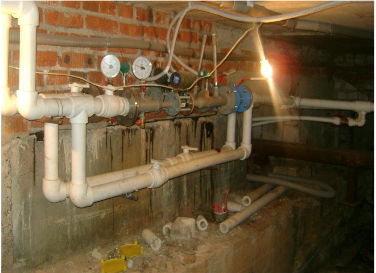
Фото 31. Техническое подполье. Следы ремонта трубопровода и приборов учета системы холодного и горячего водоснабжения. Коррозия стальных трубопроводов.
