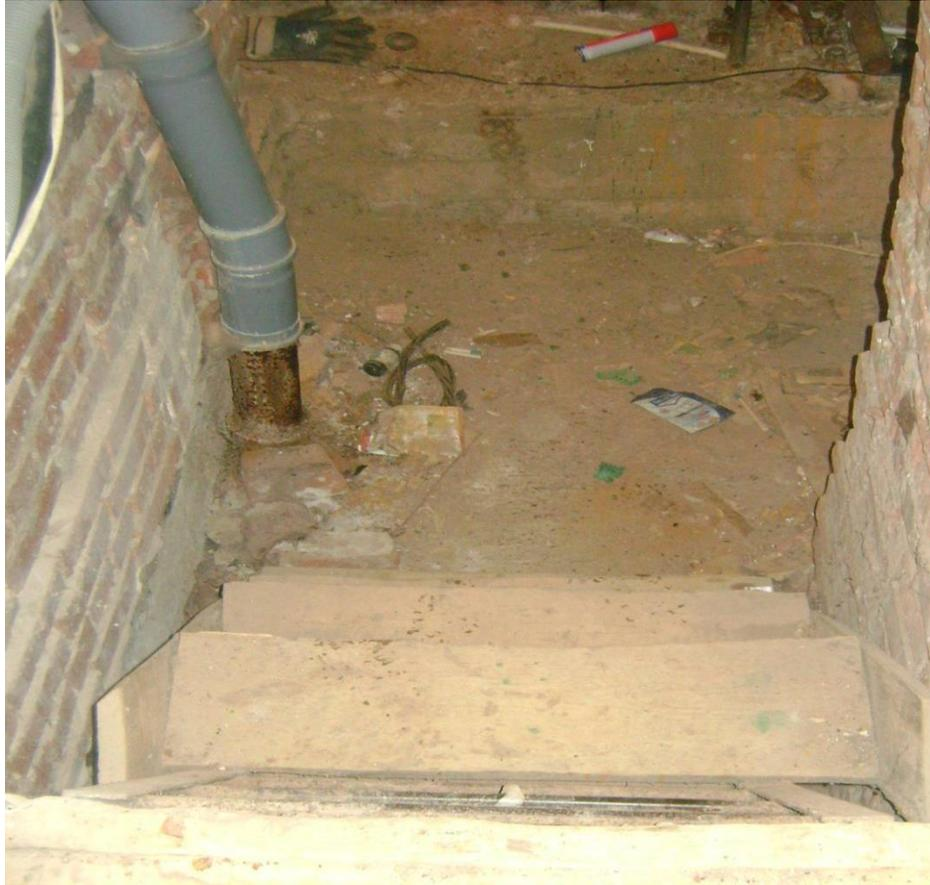
Фото 27. Спуск в техническое подполье. Канализационный стояк. Следы ремонта трубопровода. Повреждения чугунных труб.
