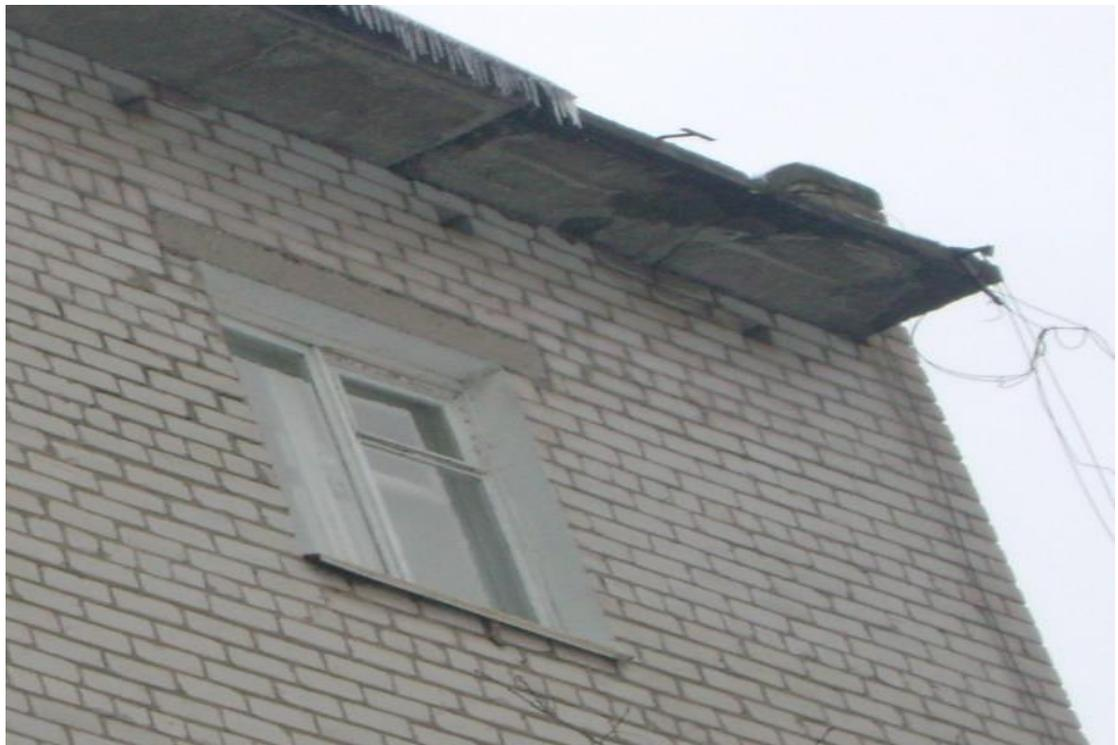
Фото 12. Фасад здания со стороны двора. Следы замачивания плит перекрытия. Образование наледи.
