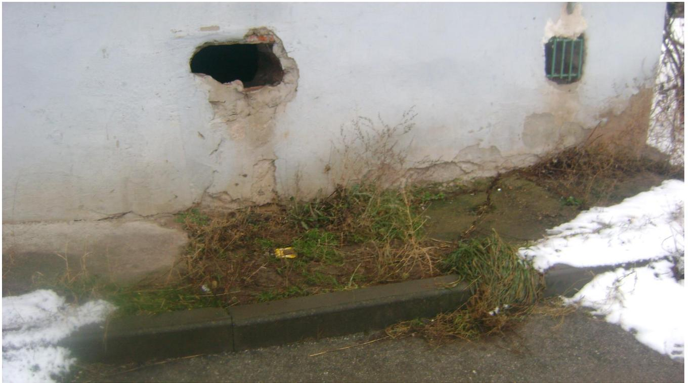
Фото 7. Отмостка с торцевой стороны здания. Разрушение, просадка, местами отсутствие отмостки. Отсутствие ограждающей решетки на отверстии для вентиляции подвального помещения.
