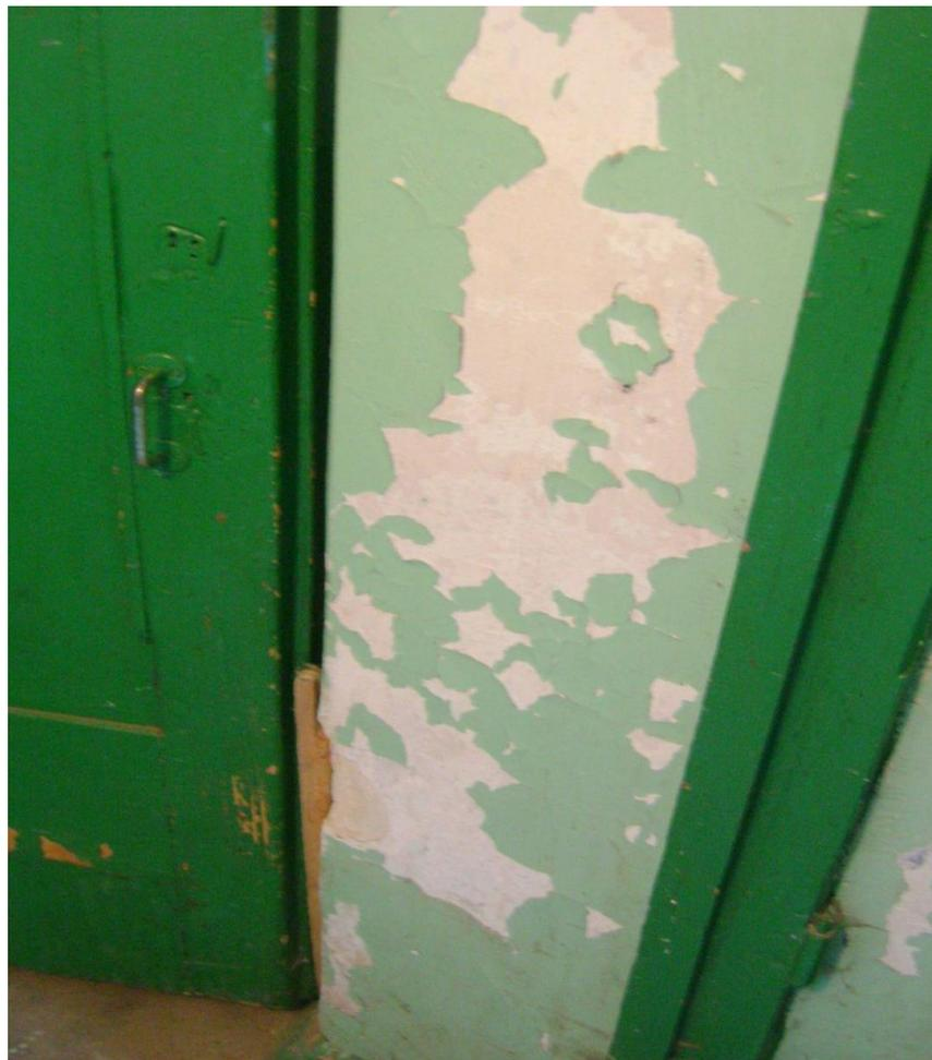
Фото 16. Подъезд. Местами отслоение, отставание, загрязнение окрасочного слоя. Повреждения внутриподъездных дверных полотен, приборов, окрасочного слоя.
