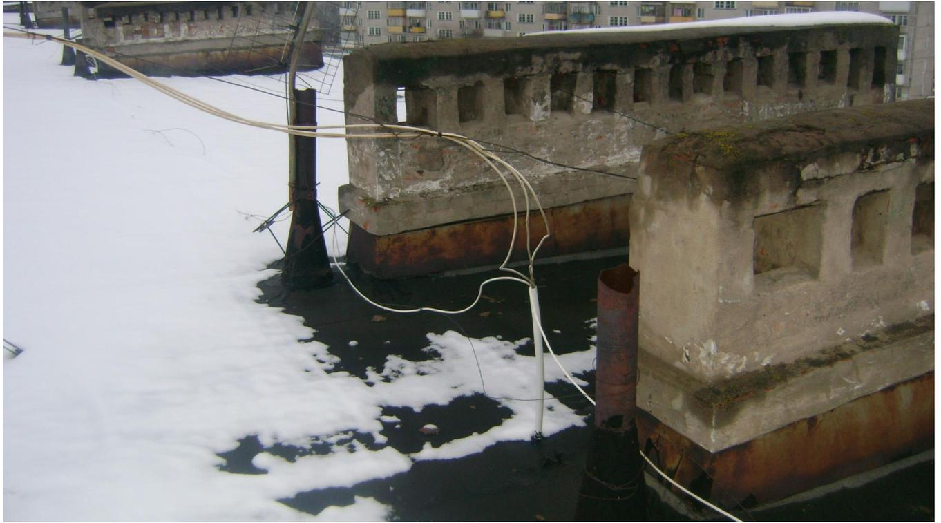
Фото 21. Крыша. Нарушение штукатурного слоя вентиляционных шахт, следы увлажнения, биокоррозия. Ржавление металлических ограждающих элементов.
