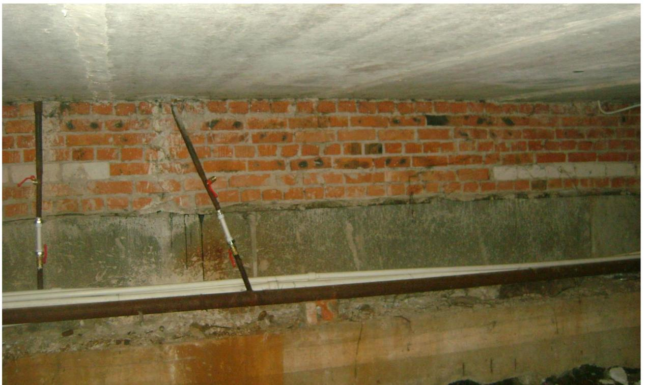
Фото 32. Техническое подполье. Выветривание швов, трещины, сколы, ржавые потеки.
