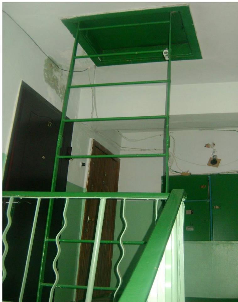
Фото 18. Подъезд. Лестница на крышу. Следы протечек.
