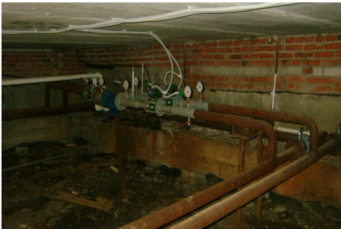
Фото 30. Техническое подполье. Поражение трубопроводов ржавчиной.
