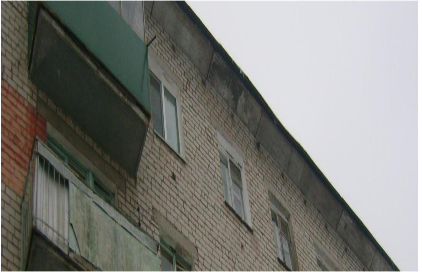
Фото 11. Фасад здания со стороны двора. Увлажнение выступающей части поверхности плит перекрытия.
