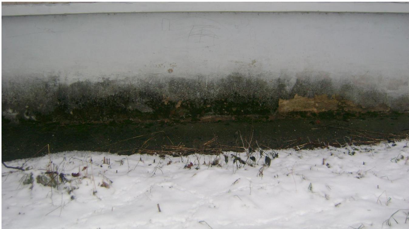
Фото 5. Фасад здания. Местные нарушения штукатурного слоя цокольной части, следы увлажнения, биокоррозия.
