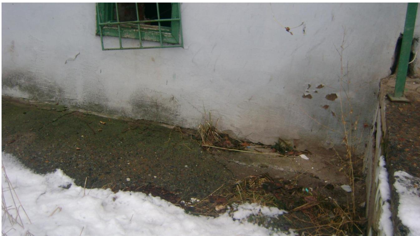
Фото 6. Фасад здания со стороны двора. Отмостка. Увлажнение, трещины, биокоррозия.
