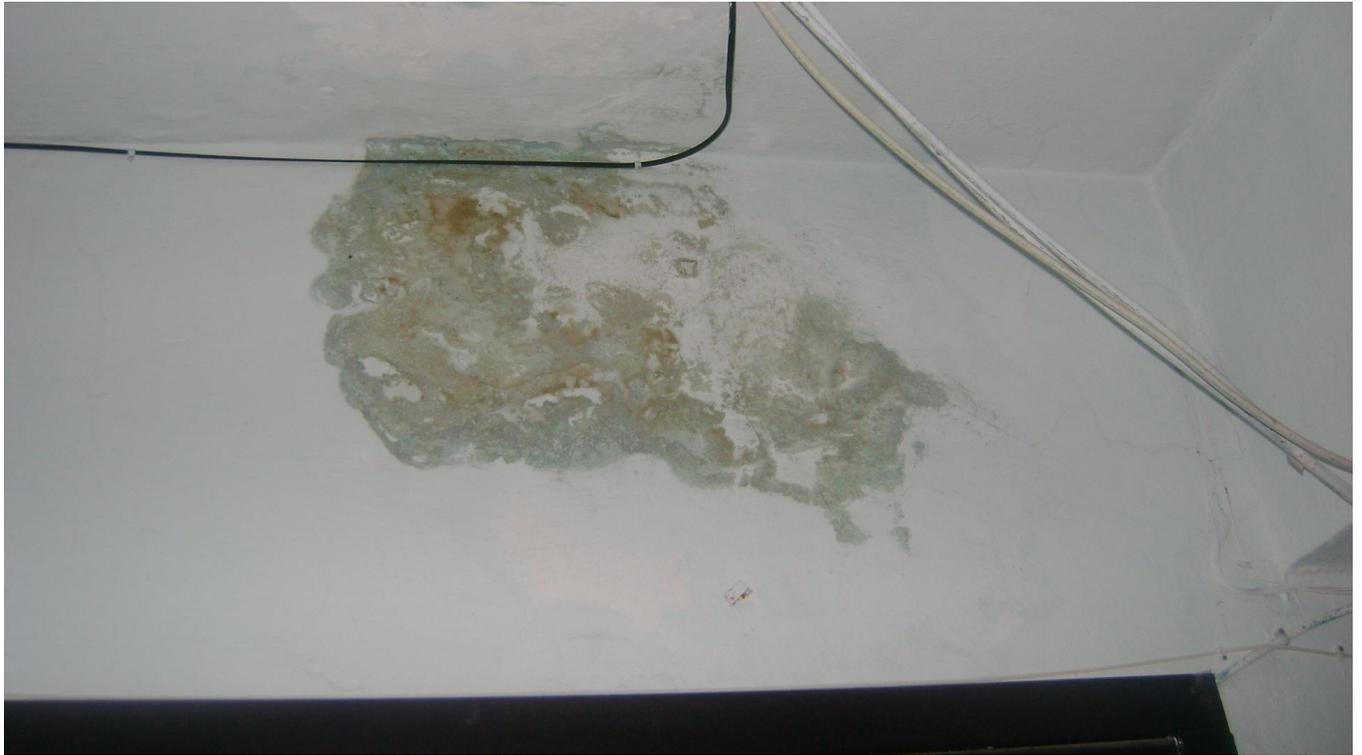
Фото 17. Следы протечек в месте опирания плиты на стену в чердачном перекрытии.
