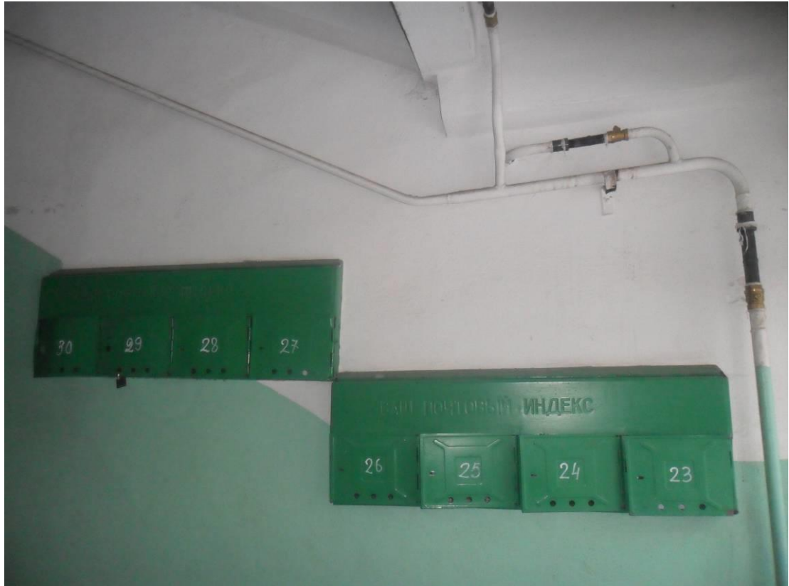
Фото 15. Подъезд. Следы ремонта сетей и запорной арматуры газоснабжения.
