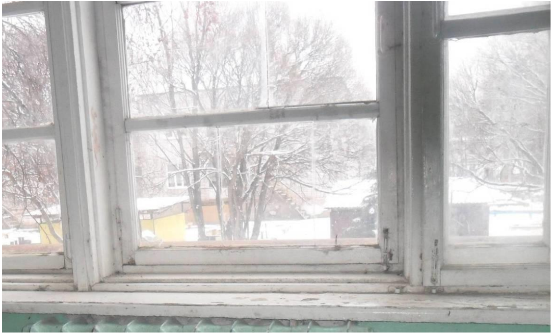
Фото 13. Подъезд. Поражение коррозией водонесущих инженерных коммуникаций системы отопления. Нарушение окрасочного слоя отопительных приборов.
