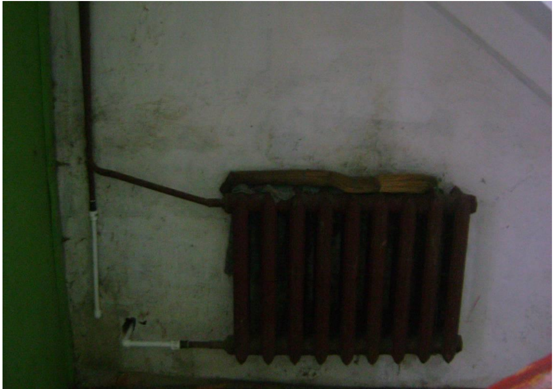
Фото 9. Подъезд. Следы ремонта. Нарушение окрасочного слоя отопительных приборов. Загрязнение побелки.
