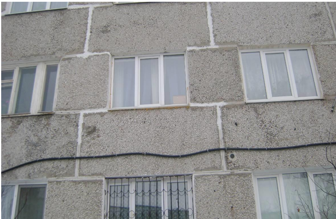
Фото 23. Фрагмент фасадной стены здания. Заделка стыков между панелями.
