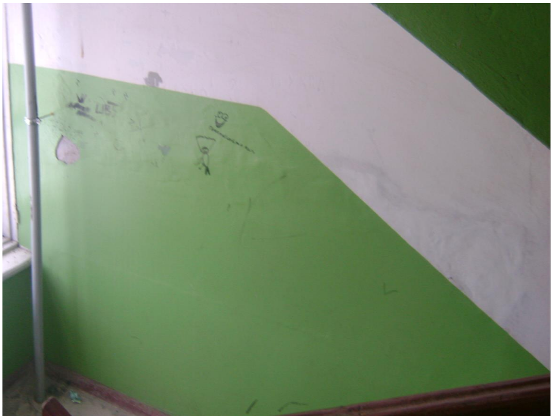
Фото 9. Подъезд. Следы ремонта. Нарушение окрасочного слоя отопительных приборов. Загрязнение побелки.
