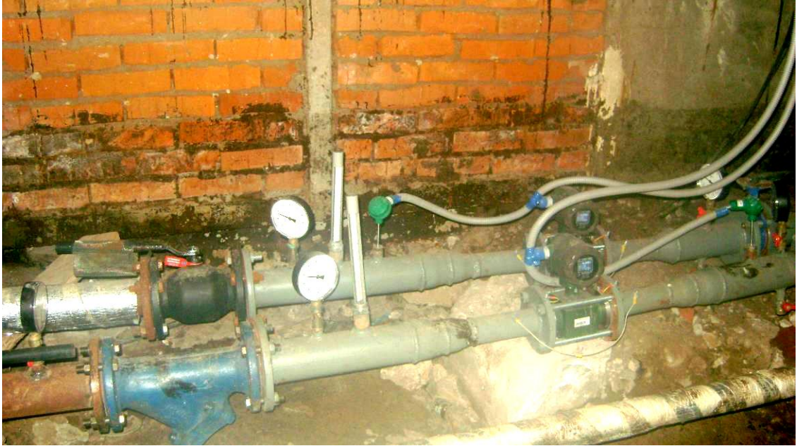
Фото 17. Техническое подполье. Замена приборов учета системы отопления.
