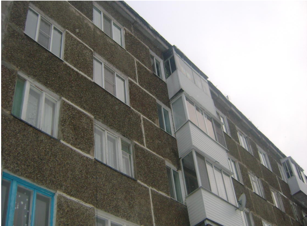
Фото 19. Фрагмент фасадной стены здания. Заделка стыков между панелями.
