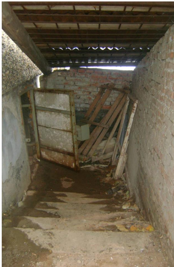
Фото 20. Вход в техническое подполье.
