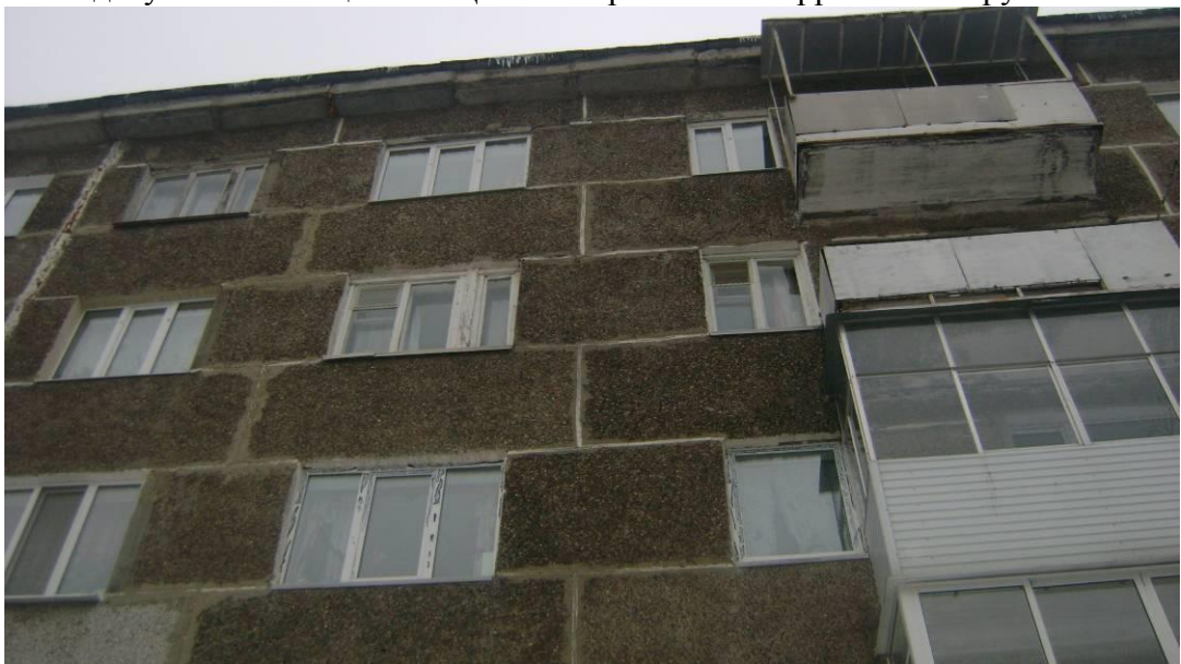
Фото 9. Выветривание раствора из швов между стеновыми панелями. Следы увлажнения стен. Следы увлажнения карнизных плит.
